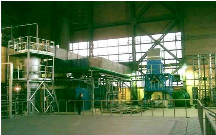
Энерготехнологический комплекс совместного производства электроэнергии и синтетического жидкого топлива из природного газа на базе газотурбинной установки мощностью 1 МВт
