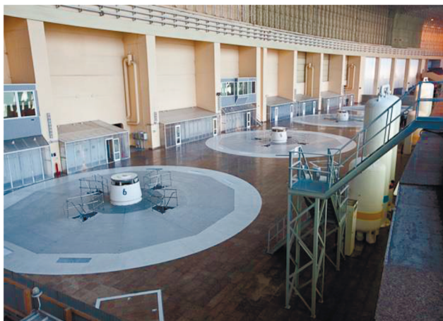
Рис. 10. Машинный зал Саяно-Шушенской ГЭС.
