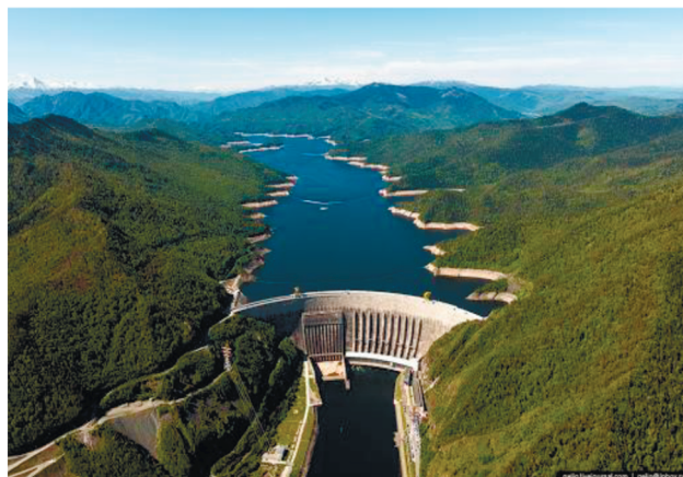
Рис. 3. Общий вид Саяно-Шушенской ГЭС.
