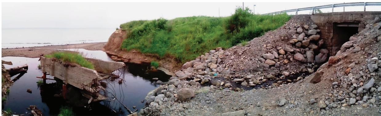
Рис. 2. Разрушение конструкций водопропускной трубы в процессе эксплуатации. Автодорога Южно-Сахалинск–Оха. Средний Сахалин, 2017 г.
