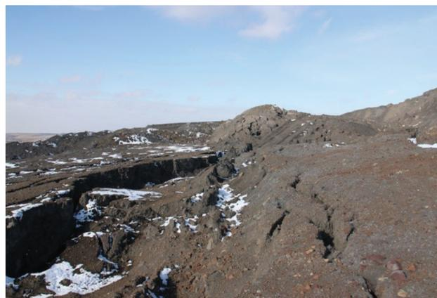
**Рис. 4.** Фото поднятой трещины сжатия в верхней части катастрофического оползня на откосе отвала в Кузбассе, 2015 г. (фото А.И. Казеева).
