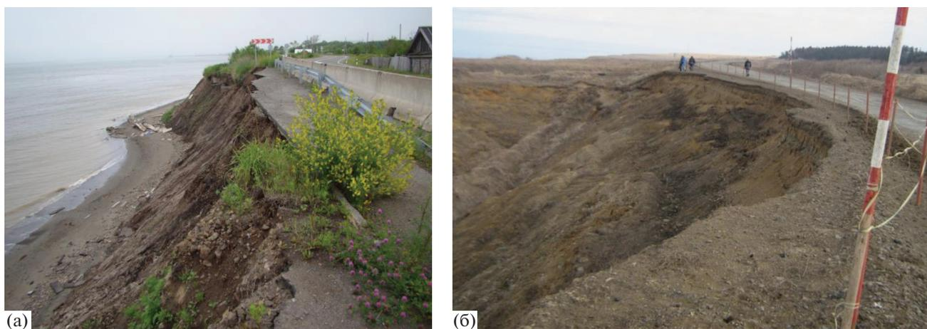
**Рис. 1.** Денудация земляного полотна: а – автодорога Южно–Сахалинск–Оха, 2017 г.; б – автодорога Невельск–Тома-ри–аэропорт Шахтерский, 2007 г.
