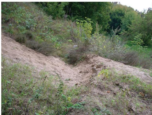
**Рис. 3.** Фото поднятой трещины сжатия у подножья откоса нового блока на участке Хорошево (Москва).
