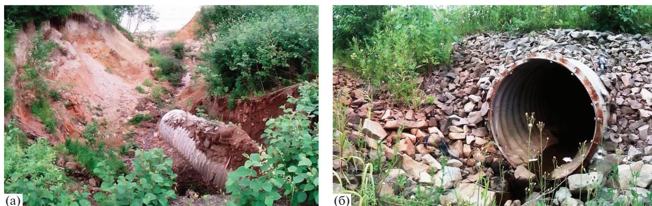
**Рис. 4.** Автодорога Южно-Сахалинск–Оха. Средний Сахалин, 2017 г.: а – разрушение нижнего бьефа; б – необорудованный входной оголовок.
