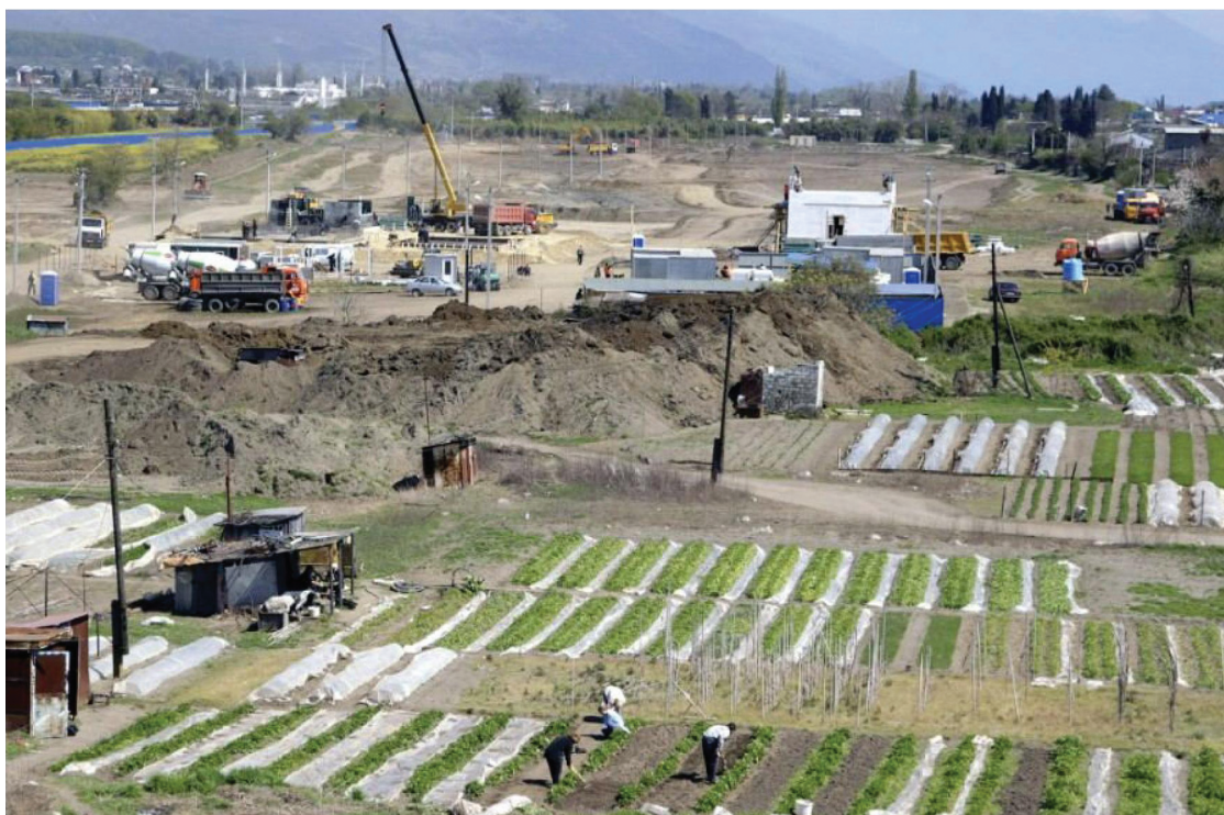
Рис. 1. Территория Имеретинской низменности после начала ее освоения для строительства олимпийских сооружений.
