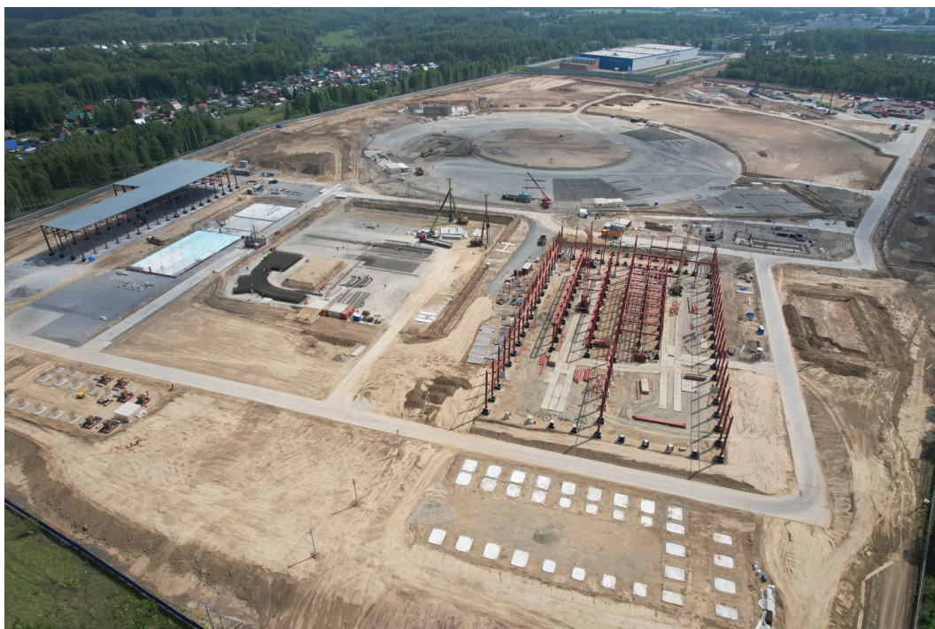
Рис. 1. Строительная площадка Центра коллективного пользования “Сибирский кольцевой источник фотонов”
