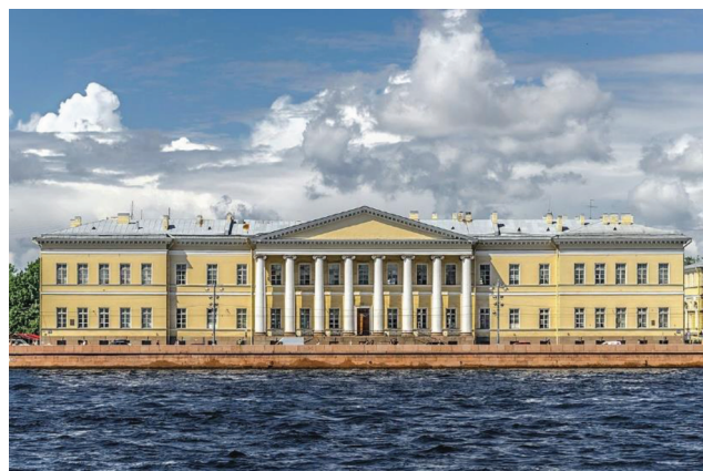
Здание Санкт-Петербургского отделения РАН на Университетской набережной, 5
