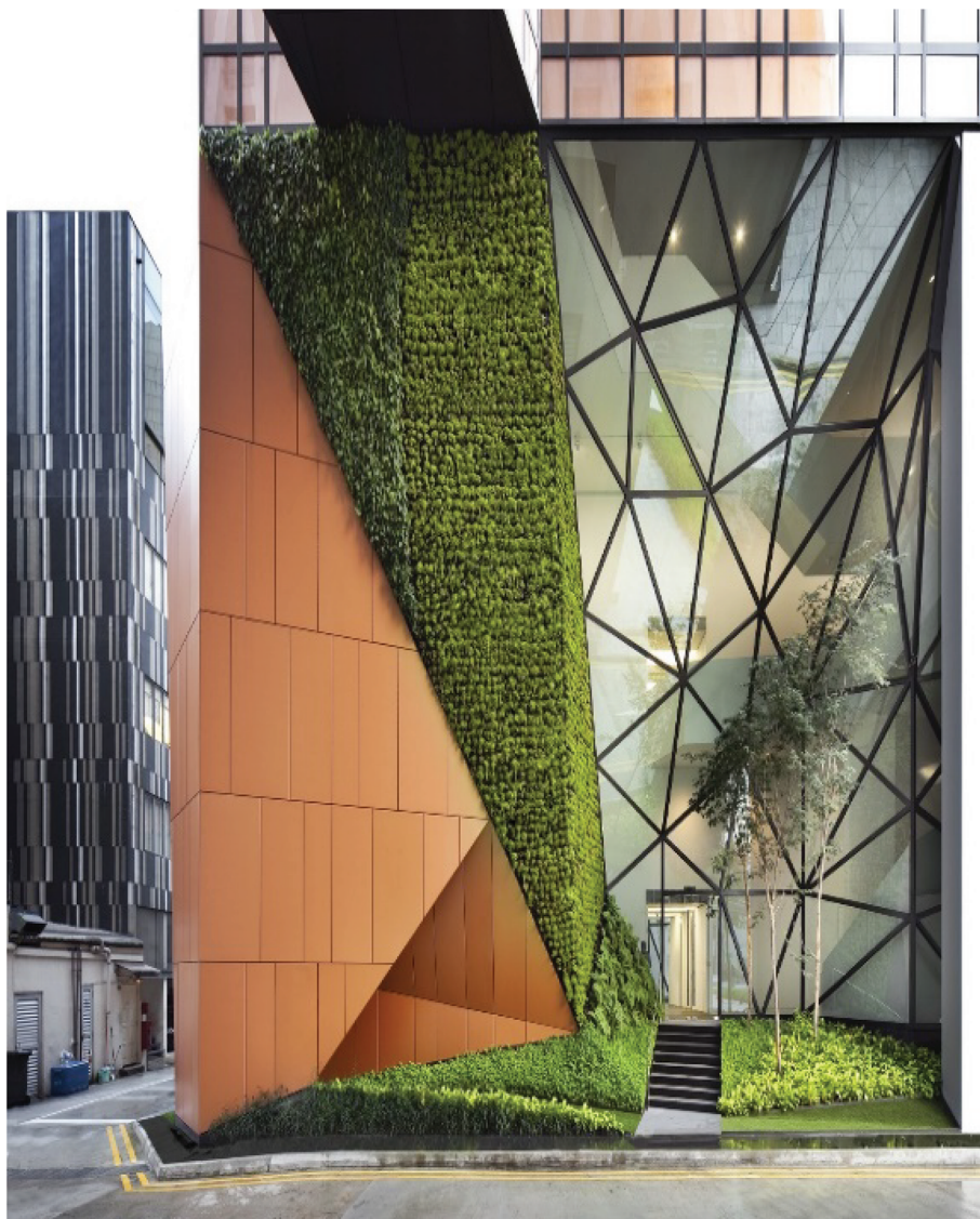
Рис. 2. Офисная и торговая башня в Сингапуре с зеленым парком в центре.
