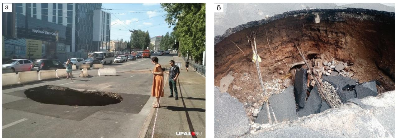
**Рис. 5.** Техногенный провал над ливневым коллектором в Уфе, ул. Цюрупа, 38: а – общий вид провала, б – свод коллектора в борту провала. Дата образования 02.07.2021. Фото А.И. Смирнова.
