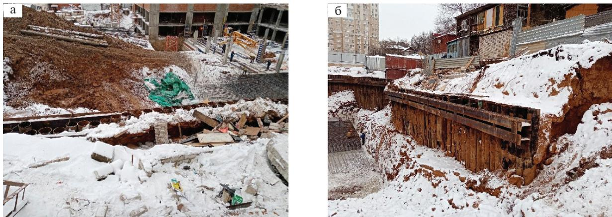
**Рис. 6.** Общий вид оползня (а) с подпорной стенкой в борту котлована (б) в Уфе (ул. Коммунистическая, д. 106). Дата образования 03.12.2019. Фото А. И. Смирнова.
