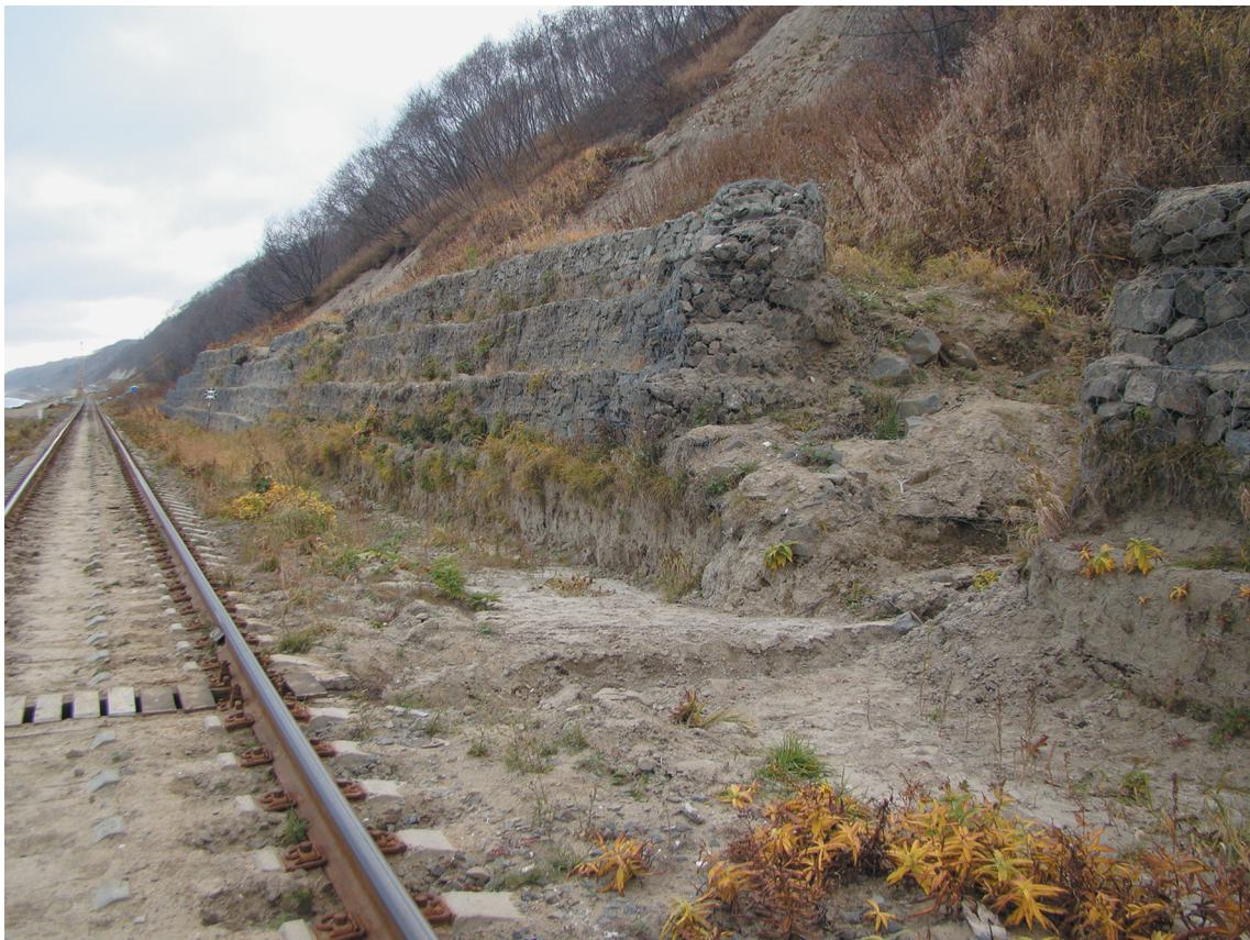
**Рис. 1.** Противооползневая подпорная стена, разрушенная склоновым селем.
