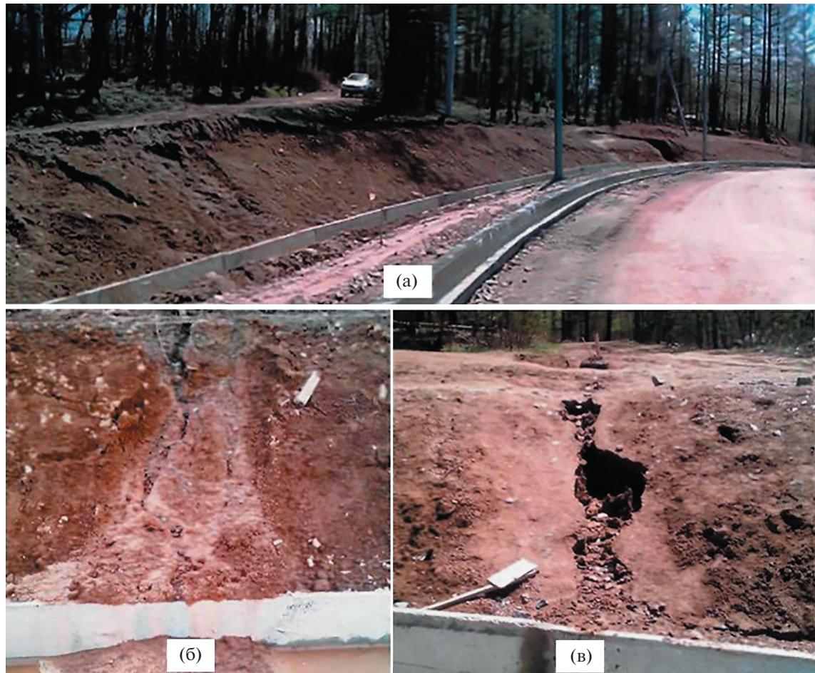
**Рис. 2.** Участок откоса автодороги с нагорной стороны, поврежденный экзогенными процессами после ливневых осадков – (а), оплынина на откосе, в результате вязкопластичной деформации грунтов (водно-гравитационный процесс) – (б) и промоина на откосе, в результате эрозии (флювиальный процесс) – (в).
