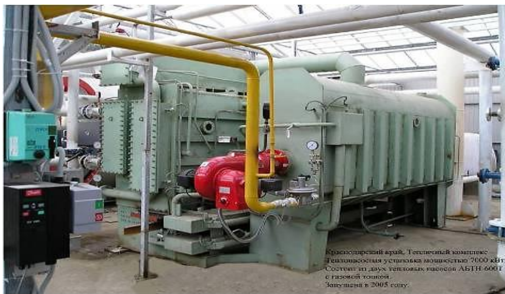
Рис. 10. Теплонасосная установка мощностью 7 МВт, состоящая из двух абсорбционных бромисто-литиевых тепловых насосов АБТН-600Т с газовой топкой (ИТ СО РАН, «Теплосибмаш»)
