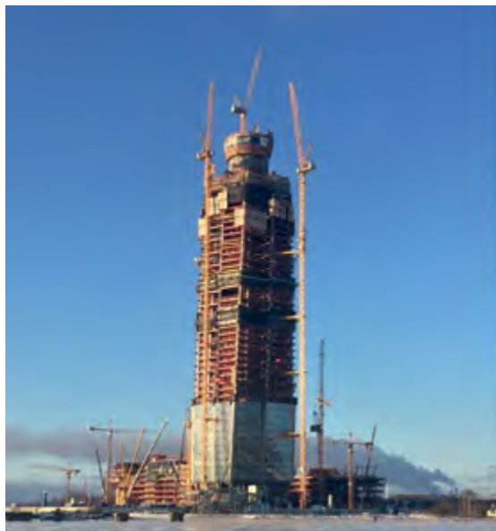
Рис. 55 «Лакhta центр». Ход строительства.
