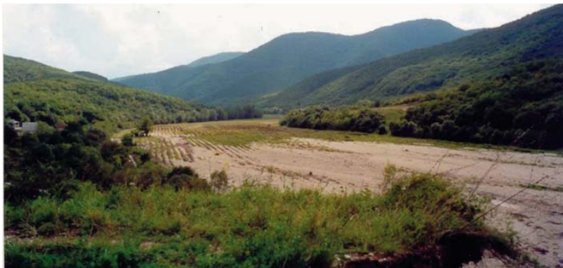
Рис. 6.2.1. Вид разрушенного гребня плотины (а) и на нижний бьеф (б): смыв весь культурный слой на пойме, уничтожено 60 га виноградников
