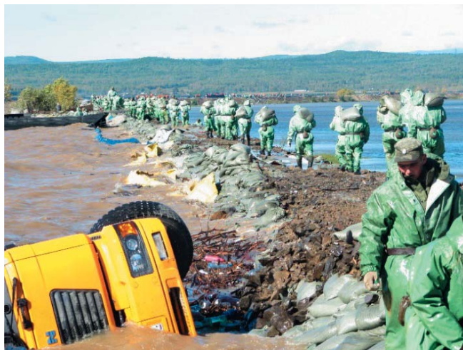
Рис. 10.1.4. Укрепление Мылkinsкой защитной дамбы мешками с песком (г. Комсомольск-на-Амуре, сентябрь 2013 г.)
