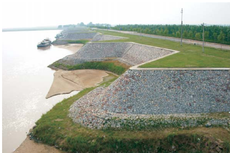
Рис. 10.1.1. Берегозащитные сооружения на р. Хуанхэ – самые мощные в мире
