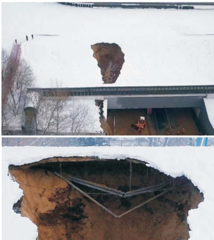
Рис. 4.1.4. Образование свища в теле дамбы Канала имени Москвы (10 января 2019 г.)
