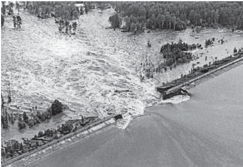
Рис. 4.1.1. Прорыв грунтовой плотины Киселевского водохранилища (фото В. Суворина, источник: https://uraloved.ru/istoriya/navodnenie-na-reke-kakva )
