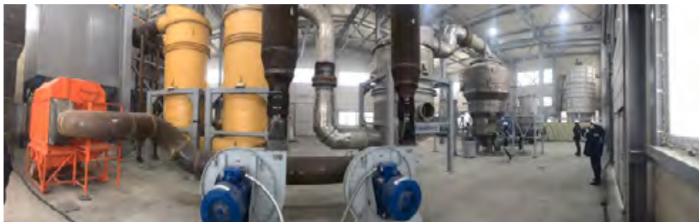
Рис. 28. Установка термокаталитического сжигания топлив
