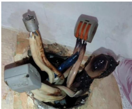
Рис. 3. Пример плавления изоляции.
