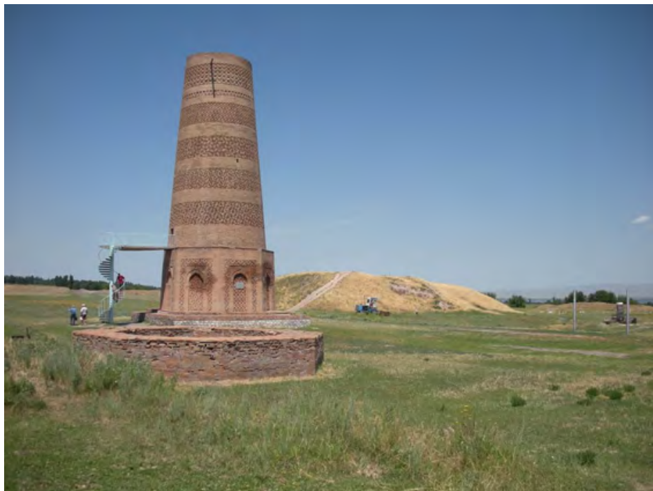
Рис. 1.21. Башня Бурана – уцелевший минарет в столице Караханидов – городе Баласагуне. Его верхняя часть обрушилась, средняя часть выдвинулась и наклонилась в сторону эпицентра одноименного землетрясения 1475 г.
