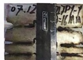
Подводная резка аустенитной стали толщиной 16 мм
