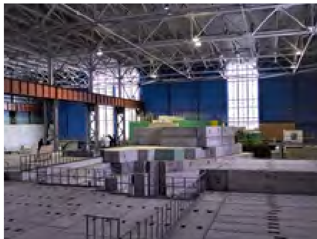
Сложенный из больших бетонных блоков «саркофаг» – защита от излучения
