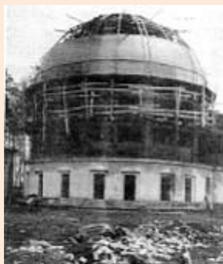
Строительство циклотрона ЛФТИ, 1940 г.
